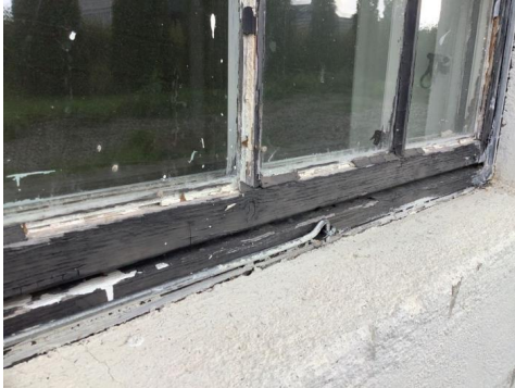
Tilstand på vindu i leilighet med koblede glass.
