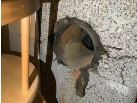
Åpent røykrør i kjeller.
