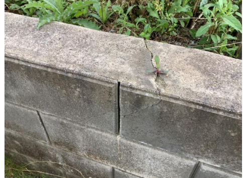
Støttemur ved leilighet.
