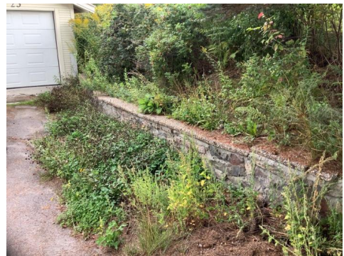
Støttemur ved garasje.
