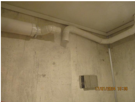
Det er lagt opp rør til sentralstøvsuger.
