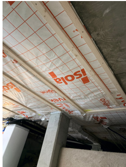
Trebjelkelag med underliggende vindsperre.
