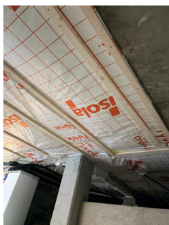
Trebjelkelag med underliggende vindspærre.
