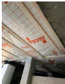
Trebjelkelag med underliggende vindsperre.
