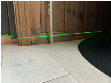
Etasjeskillet er kontrollert med nivelleringslaser.
