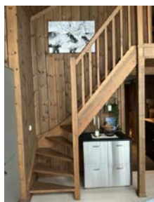
Åpen tretrapp mellom etasjene.
