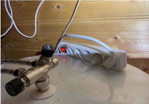
Elektrisk tilkobling på skjøtekontakt.
