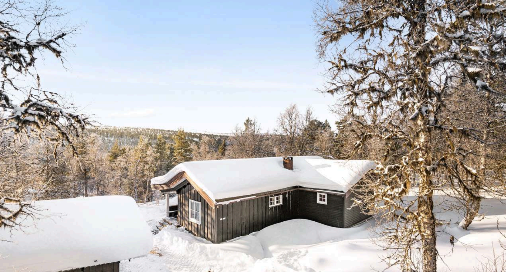
Fasaden sett fra nord-øst.
