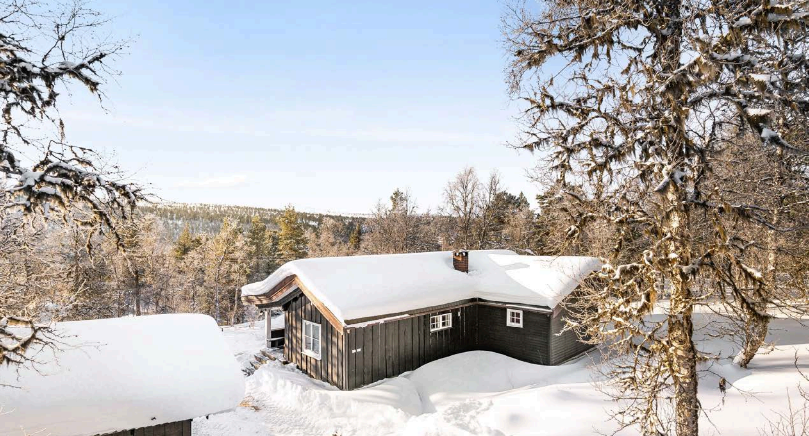
Fasaden sett fra nord-øst.
