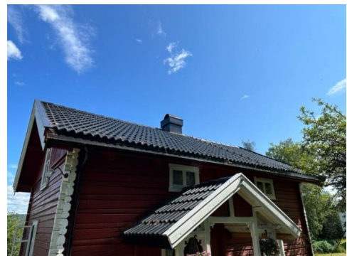
Besiktigelse av taktekke.
