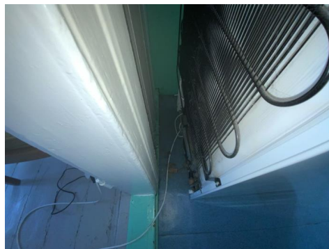
Kontroll bak kjøleskap. Ingen tegn til fuktskader på befaringsdagen.
