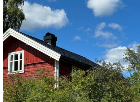
Besiktigelse av taktekke.
