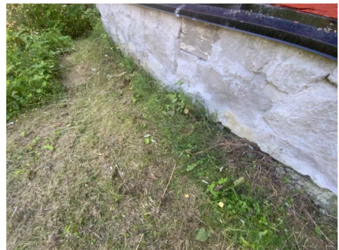
Kontroll av drenering/fuksikring.
