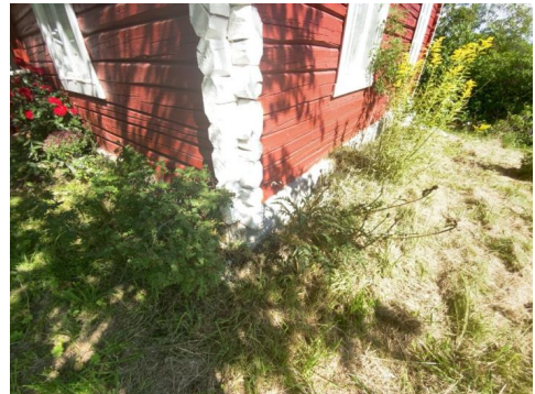
Kontroll av drenering/fuksikring.
