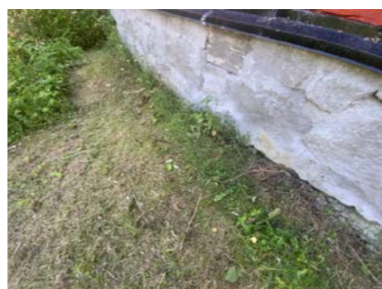
Kontroll av drenering/fuktsikring.
