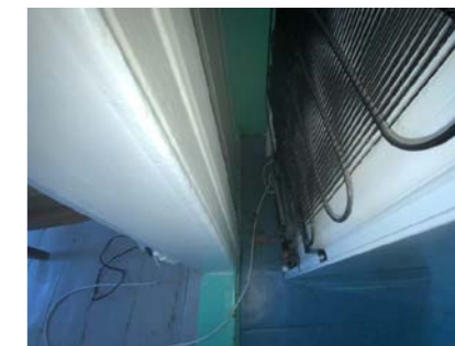
Kontroll bak kjøleskap. Ingen tegn til fuktskader på befaringsdagen.
