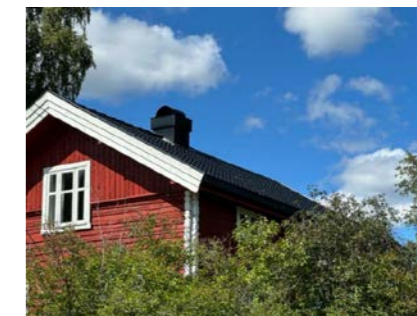
Besiktigelse av taktekke.
