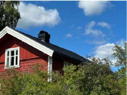
Besiktigelse av taktekke.
