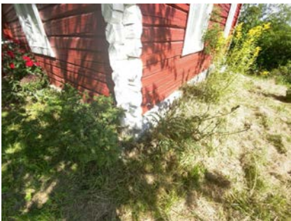
Kontroll av drenering/fuktsikring.
