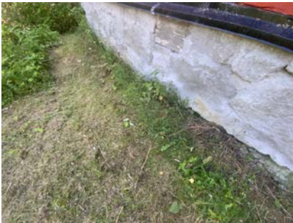
Kontroll av drenering/fuktsikring.
