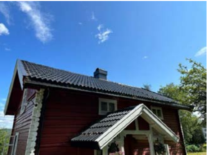
Besiktigelse av taktekke.
