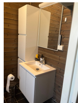
Trepanel på våtsone til servant.
