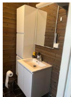
Trepanel på våtsone til servant.
