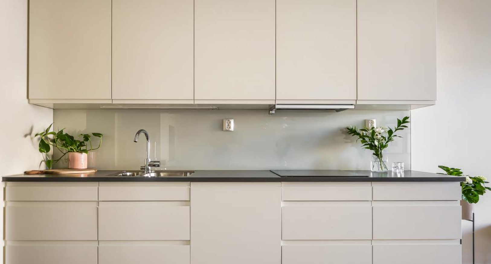
Over platetoppen er det montert en ventilasjonshette koblet på byggets ventilasjonsanlegg.
