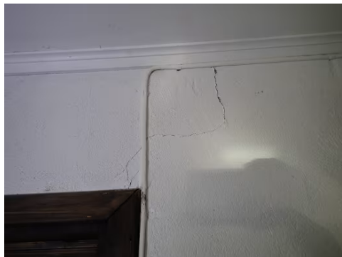
Innvendig grunnmursvegg (innervegg)
