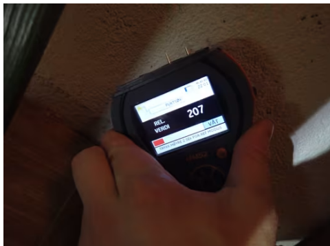
Tilfeldig måling i nedre del av vegg i underetasje
