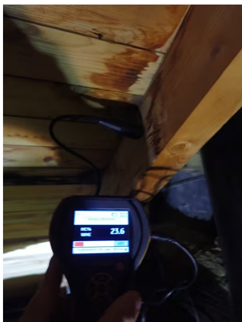
Fuktmåling ved kanalføring
