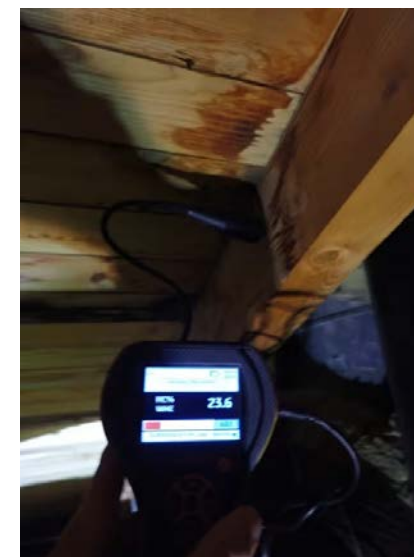
Fuktmåling ved kanalføring
