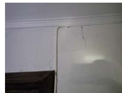
Innvendig grunnmursvegg (innervegg)
