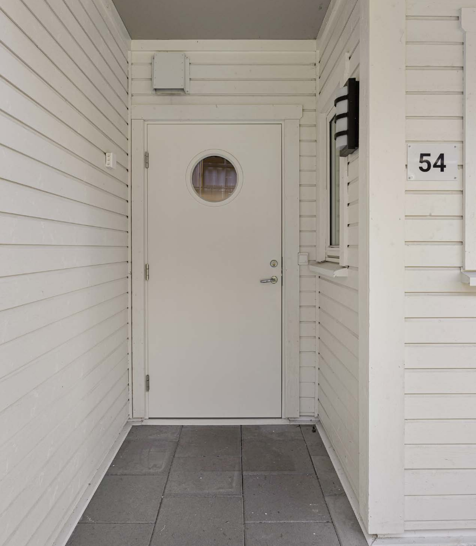
Inngangsdøren har vindu.
