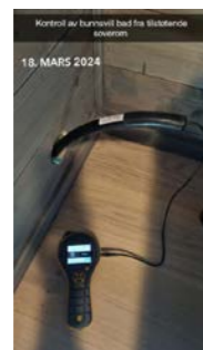
Kontroll av bunnvill bad fra tilstøtende soverom. Ingen fuktavvik
