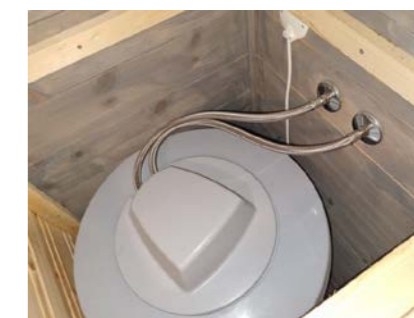
Oversikt tank sett ovenfra
