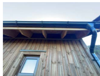
Synlig ventilering i overgang vegg /tak utvendig
