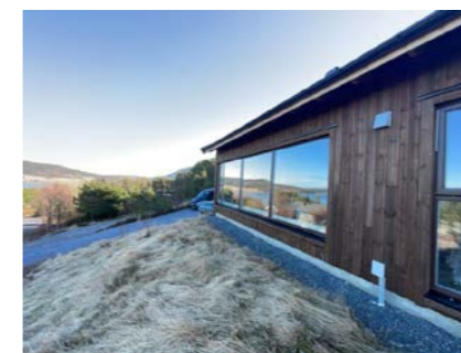
Vinduer på stue
