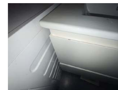
Overflateskade på skuffefront under servant
