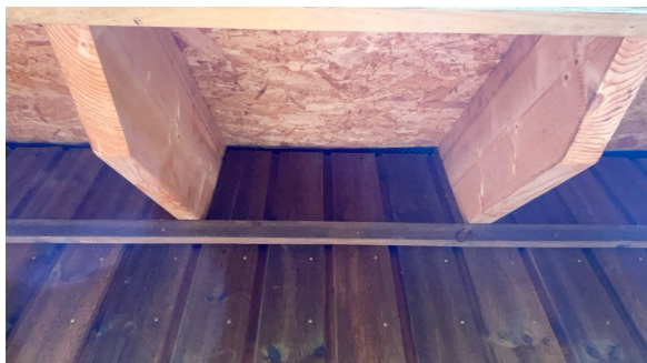
Synlig ventilering i overgang vegg /tak utvendig
