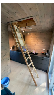
Loftstrapp i himling over kjøkken til lagringshems
