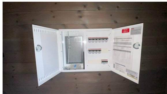
Utvendig hovedskap med overspenningsvern, AMS Strømmåler og Sikringsskap på soverom hovedsikring på 63 AMP
