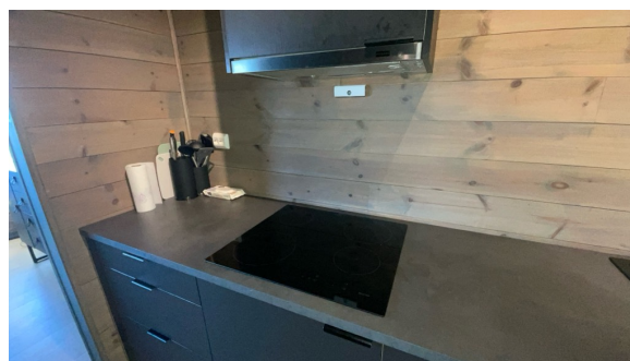
Anbefaler å få montert sikring mot sprut ved platetopp og ved servant
