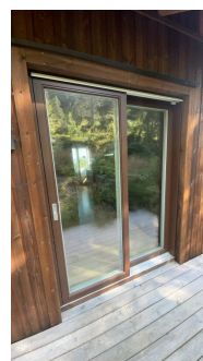
Skyvedør fra kjøkken ut til terrasse
