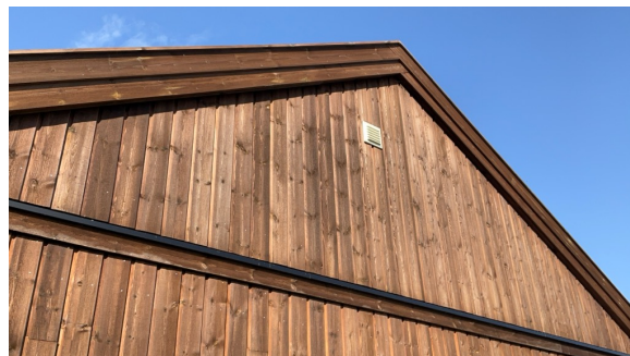
Ventilering av hemsrom over kjøkken via ventil
