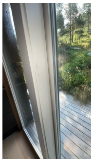
Overflateslitasje innvendig på skyvedør
