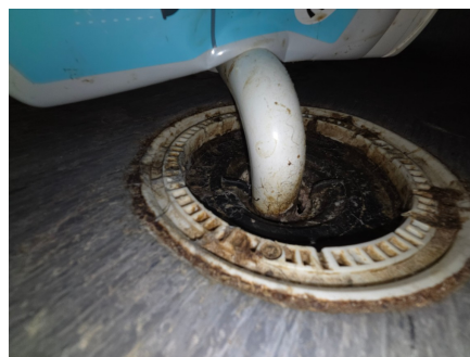
Sluk. Sluk bør jevnlig rengjøres
