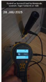
Kontroll av bunnsvill bad fra tilstøtende soverom. Ingen fuktavvik
