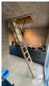
Loftrapp i himling over kjøkken til lagringshems
