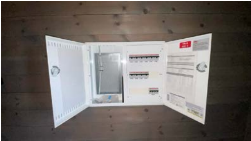
Utvendig hovedskap med overspenningsvern, AMS Strømmåler og Sikringsskap på soverom hovedsikring på 63 AMP
