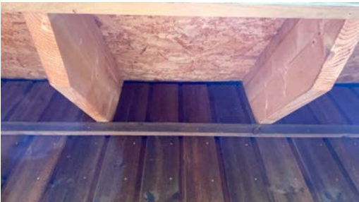
Synlig ventilering i overgang vegg /tak utvendig
