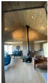
Takkonstruksjon sett fra stue mot hems over kjøkken med lagerrom
