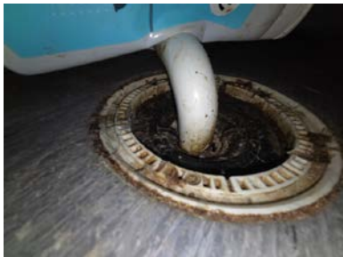
Sluk. Sluk bør jevnlig rengjøres
