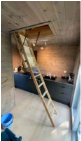
Loftrapp i himling over kjøkken til lagringshems
