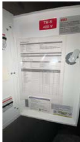
Utvendig hovedskap med overspenningsvern, AMS Strømmåler og Sikringsskap på soverom hovedsikring på 63 AMP
