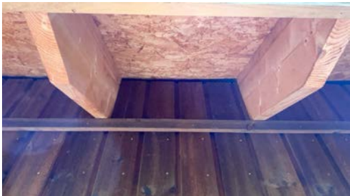
Synlig ventilering i overgang vegg /tak utvendig
