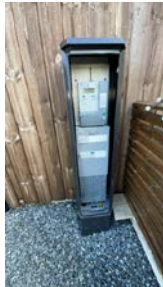
Utvendig hovedskap med overspenningsvern, AMS Strømmåler og Sikringsskap på soverom hovedsikring på 63 AMP
