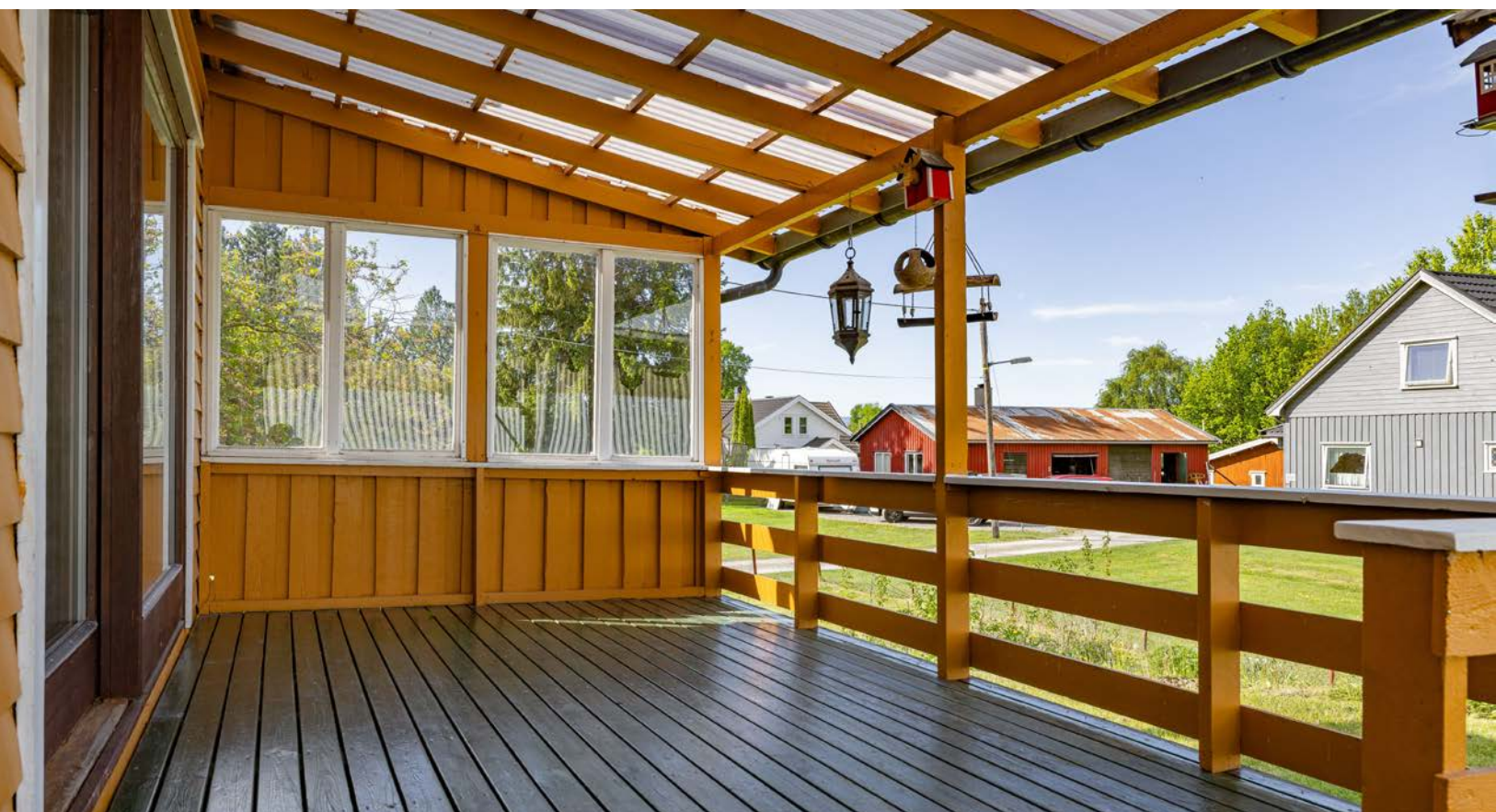
Terrassen er ovebygd og er på ca. 11 m².
