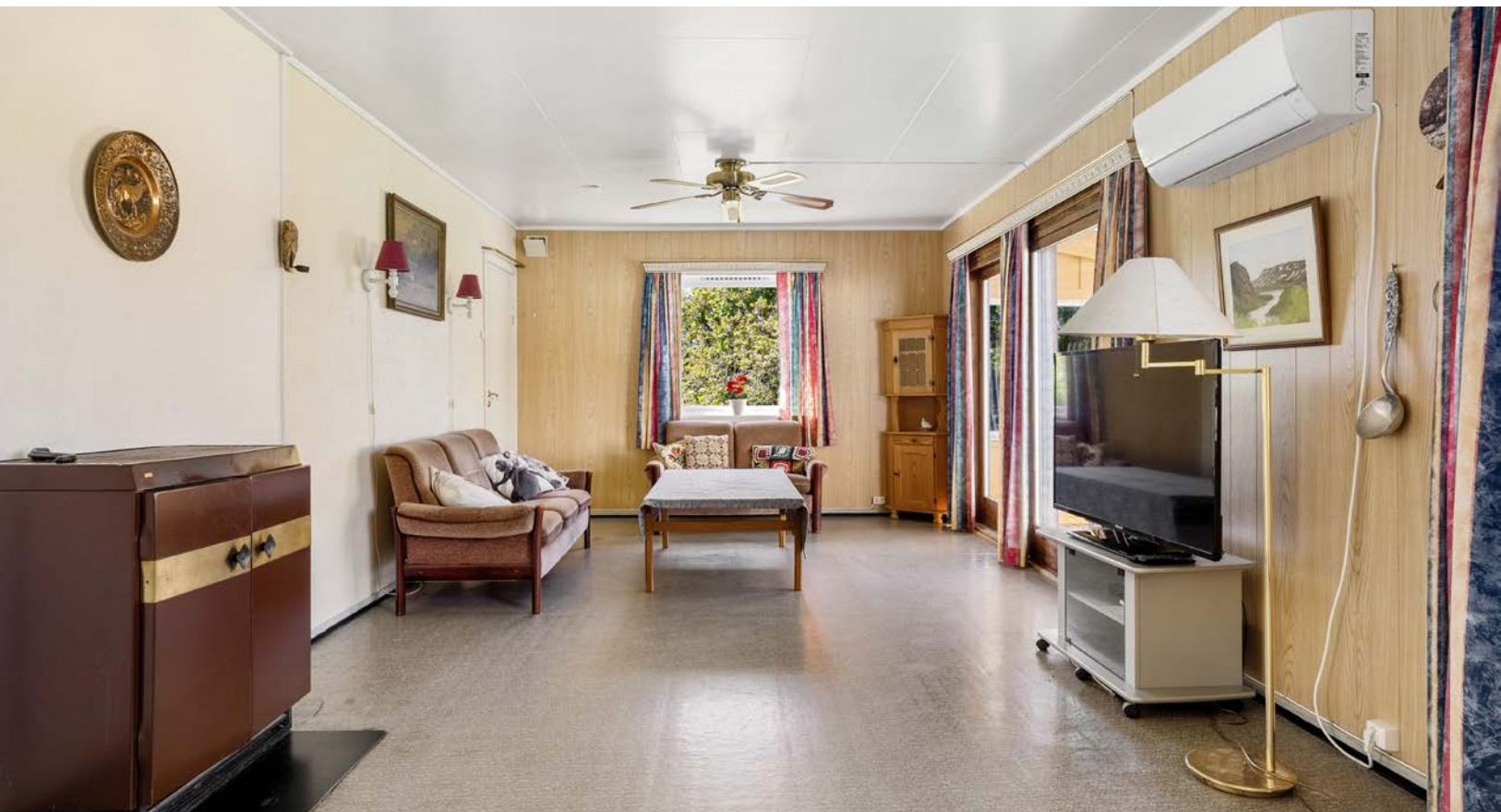
Det er montert varmepumpe for jevn og god varme.
