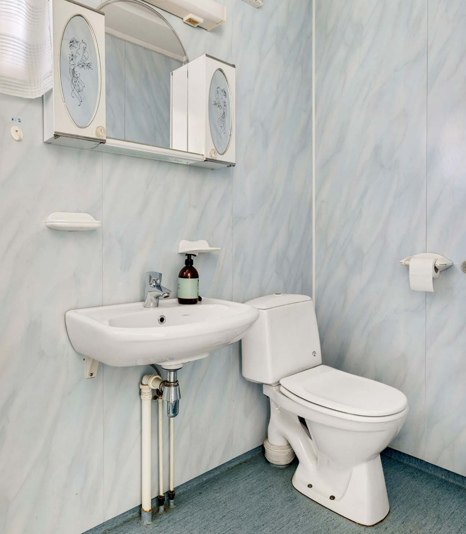
Badet ligger i 1. etasje og har belegg på gulvet og baderomsplater på veggene. Det har gulvmontert toalett og veggmontert håndvask. Veggskap, speil og lys med elektrisk uttak over servanten.
