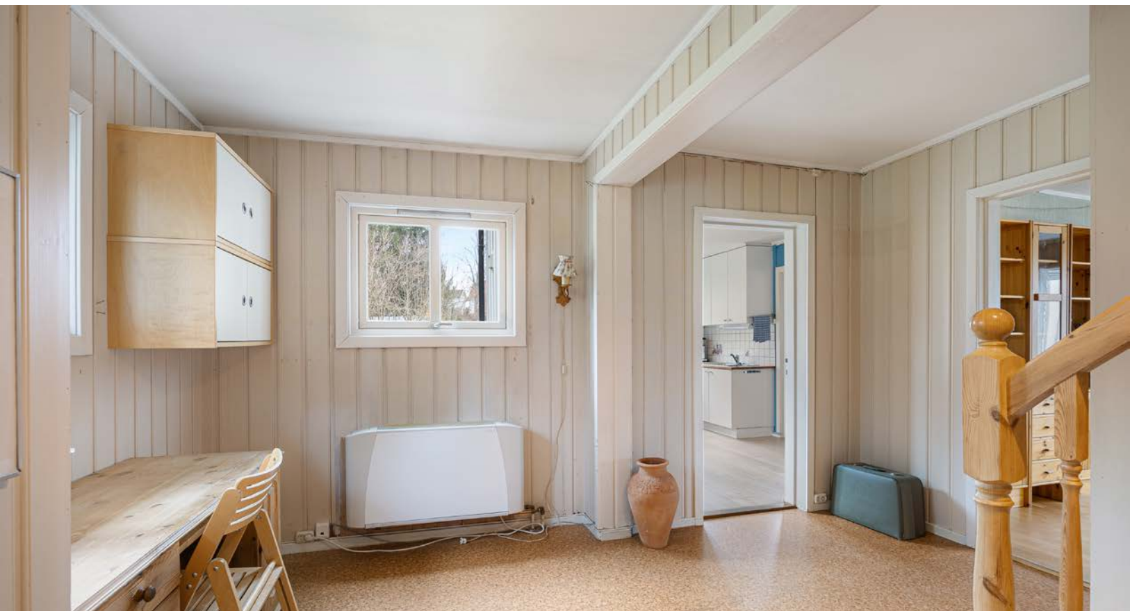
Veggene har lysmalt panel, og på gulvet er det belegg. I entréen er det en nyere viftekonvektor - vann til luft.
