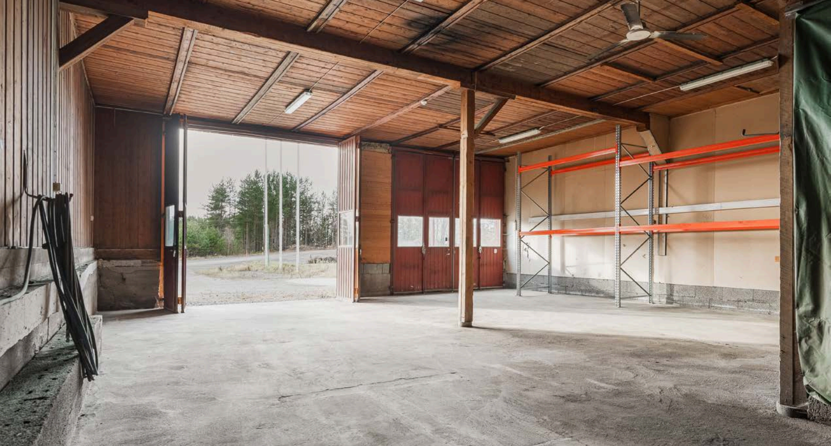
Garasje med betonggulv, vegger med bord/gips og himling med trebord. Intern ståltrapp ved garasje med åpne opptrinn og rekkverk.
