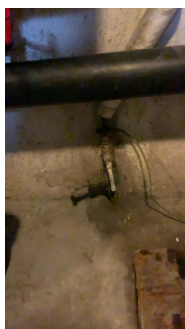
Hovedstoppekrane er plassert i vaskekjeller.
