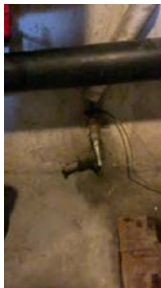
Hovedstoppekrane er plassert i vaskekjeller.
