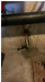
Hovedstoppekrane er plassert i vaskekjeller.
