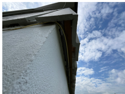
Ny luftet kledning i front og eldre på gavlveggen.
