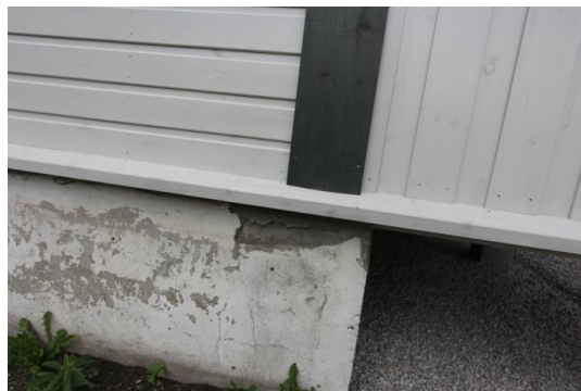
Grunnmur av betong/ stein.
