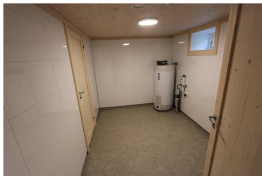
Vaskerom i kjeller.
