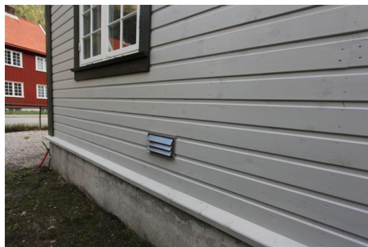
Grunnmur av betong/ stein.
