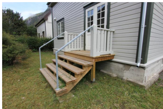
Trapp ut fra stue.
