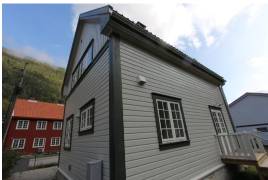
Utvendige vegg overflater.
