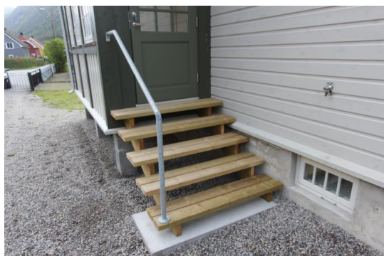
Utvendig trapp til hovedinngang.
