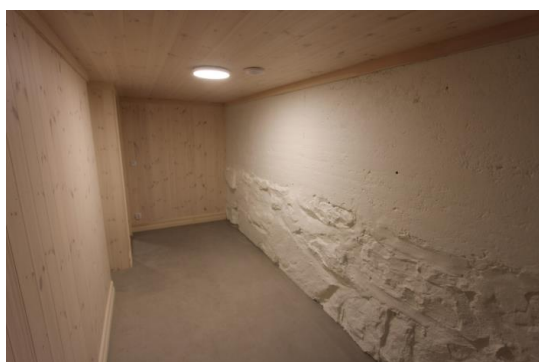
Betong gulv i kjeller.
