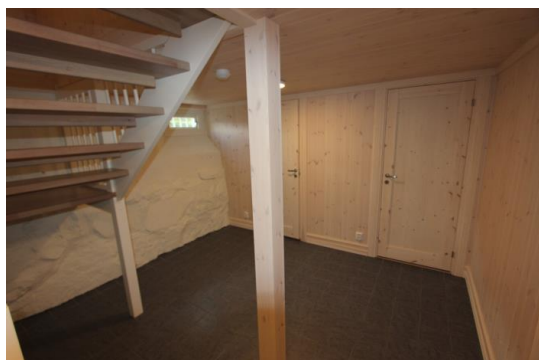
Betong gulv i kjeller tildekket med fliser.
