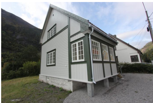
Utvendige vegg overflater.
