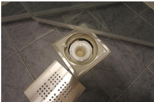
Sluk med slukmansjett.
