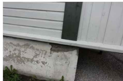
Grunnmur av betong/ stein.
