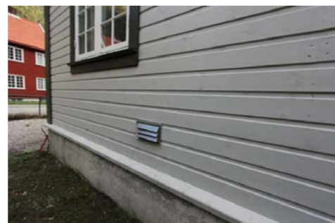
Grunnmur av betong/ stein.
