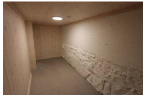
Betong gulv i kjeller.
