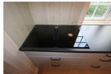
Benkmontert avtrekk.
