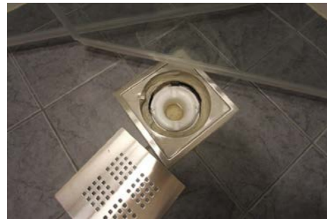
Sluk med slukmansjett.
