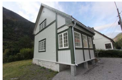
Utvendige vegg overflater.
