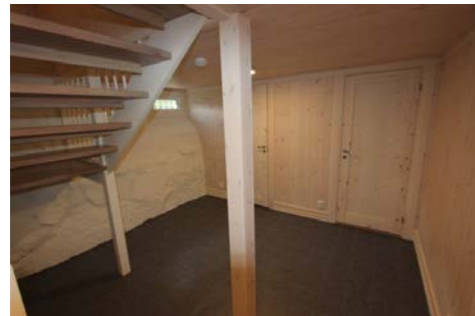
Betong gulv i kjeller tildekket med fliser.
