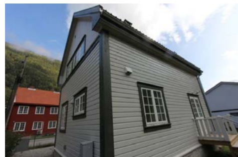
Utvendige vegg overflater.
