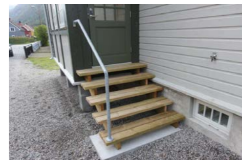
Utvendig trapp til hovedinngang.
