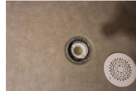
Sluk med klemring vaskerom.
