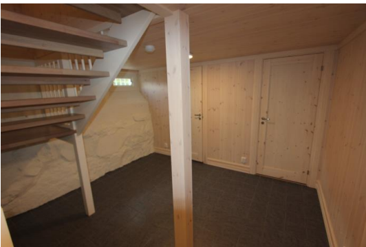
Betong gulv i kjeller tildekket med fliser.
