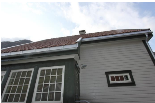
Tak tekket med flat takstein.
