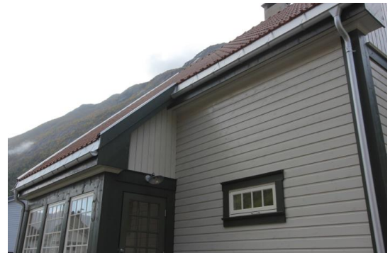
Tak tekket med flat takstein.
