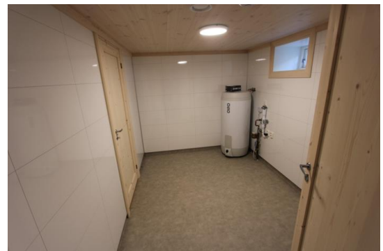
Vaskerom i kjeller.
