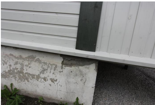
Grunnmur av betong/ stein.
