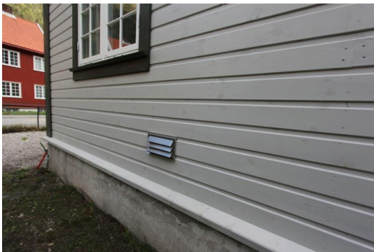
Grunnmur av betong/ stein.
