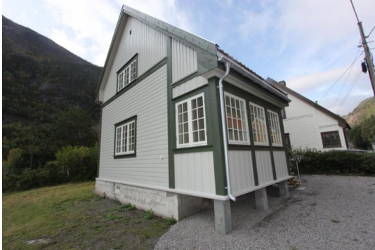
Utvendige vegg overflater.
