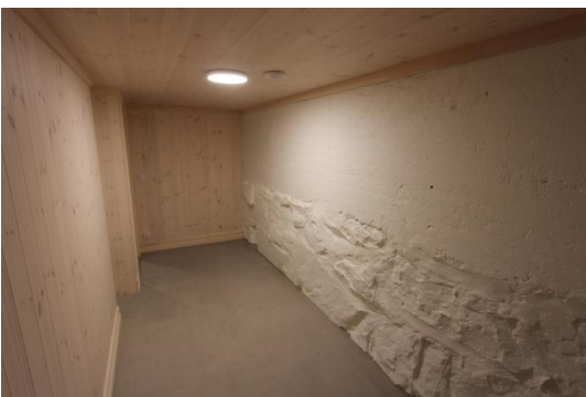
Betong gulv i kjeller.
