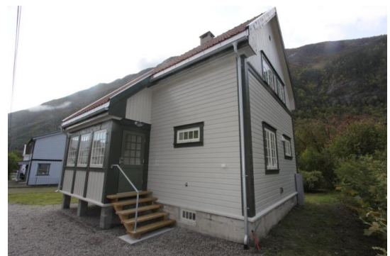
Blikk og takrenner beslag og nedløp.
