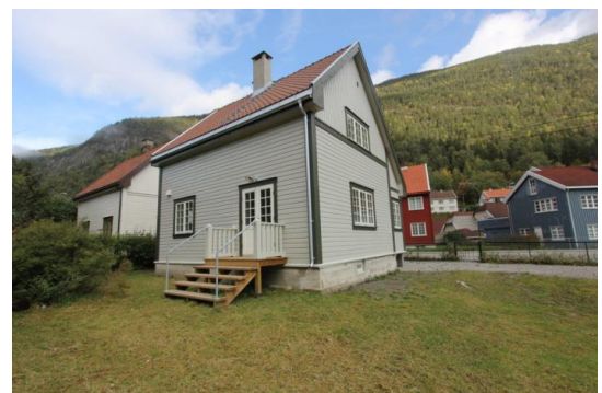
Blikk og takrenner beslag og nedløp.
