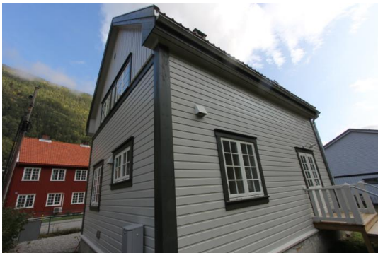
Utvendige vegg overflater.
