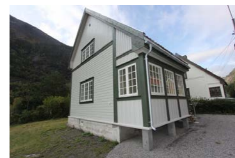
Utvendige vegg overflater.
