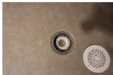
Sluk med klemring vaskerom.
