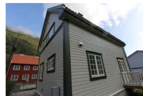
Utvendige vegg overflater.
