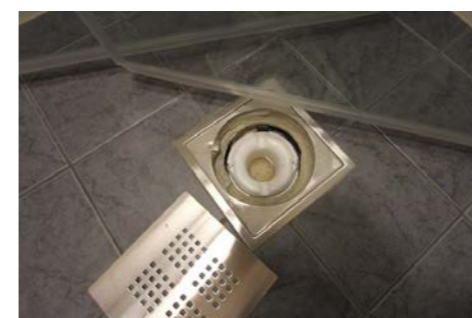
Sluk med slukmansjett.
