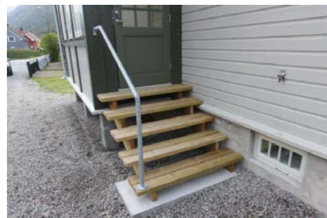
Utvendig trapp til hovedinngang.
