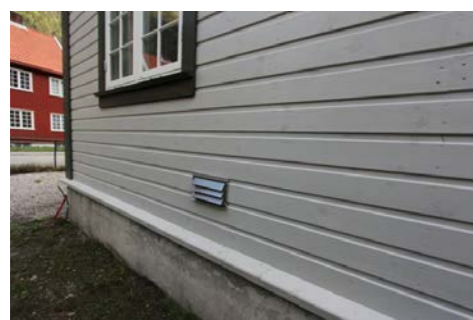
Grunnmur av betong/ stein.
