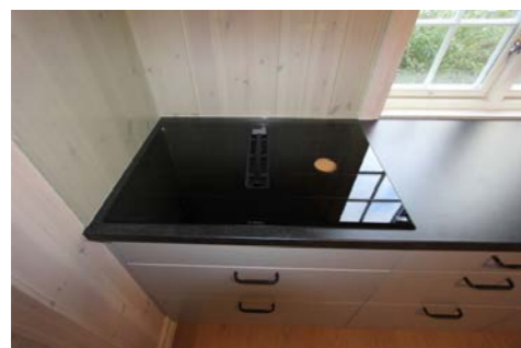
Benkmontert avtrekk.
