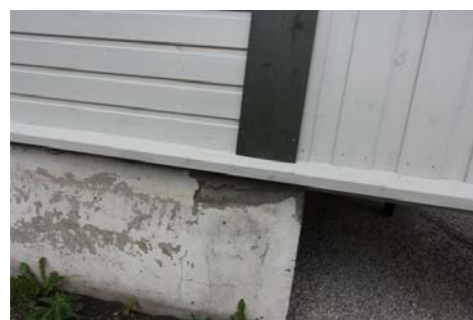
Grunnmur av betong/ stein.
