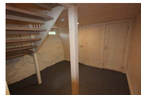
Betong gulv i kjeller tildekket med fliser.
