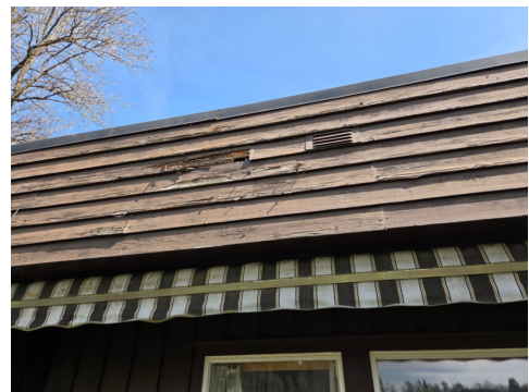
Synlig råteskader i fasadepanel
