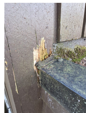
Synlig råteskader i fasadepanel
