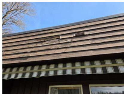
Synlig råteskader i fasadepanel
