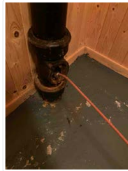
Stakeluke i kjeller. Her starter inspeksjonen.
