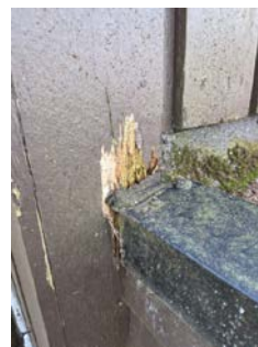
Synlig råteskader i fasadepanel
