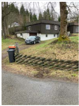
Boligen. Det er gatesluk i veiskulderen
