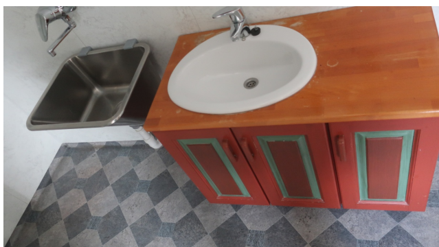
Stål skyllekum og baderomsinnredning med servant.
