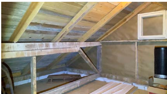
Loftet over garasjen.
