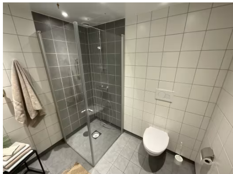
Viser dusjsone og vegghengt toalett med innebygget sistene.
