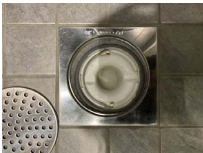
Viser sluk i dusjsonen.
