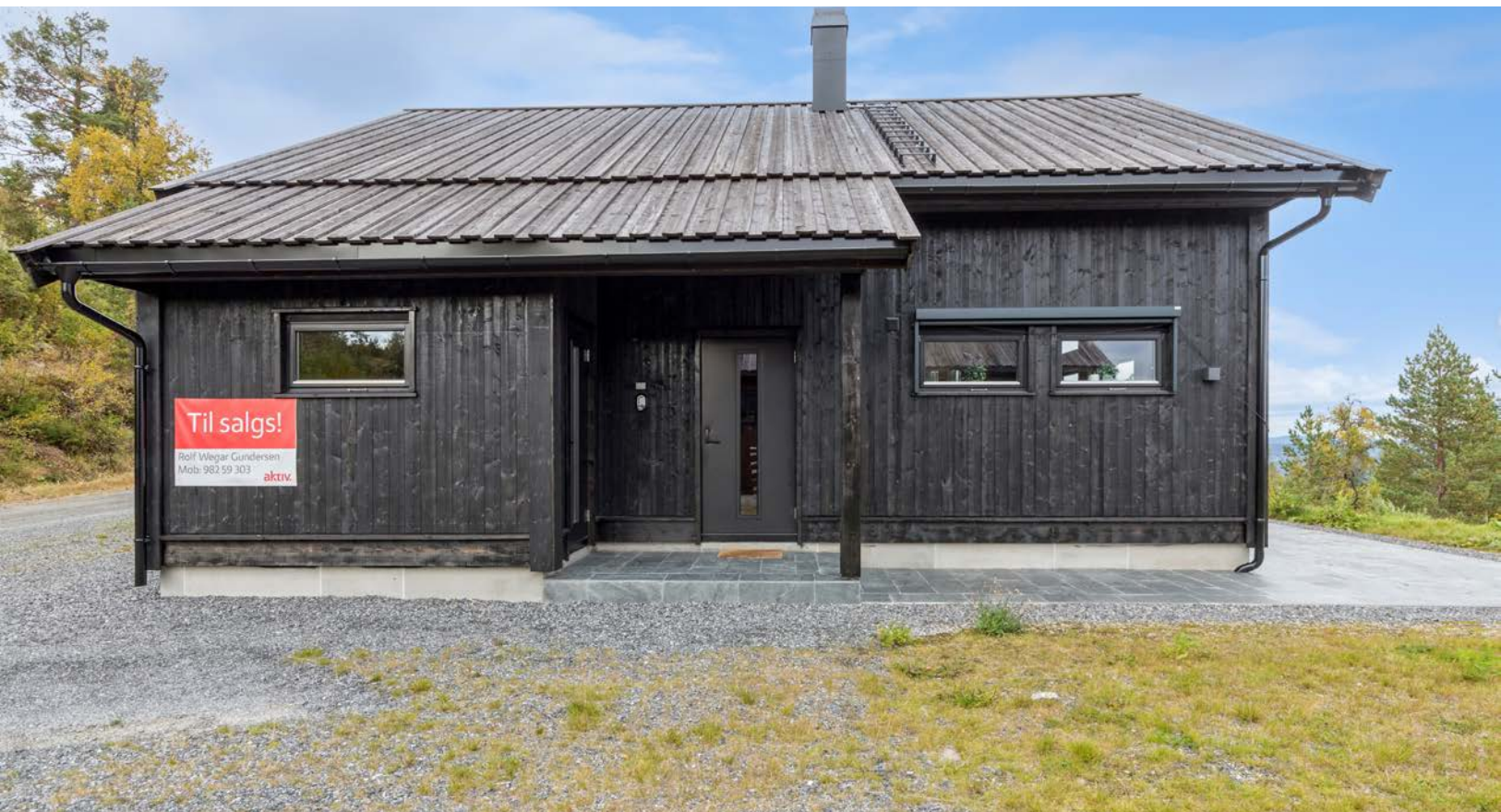
Overbygget inngangsparti samt tilgang til den utvendige isolerte boden
