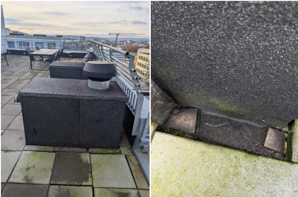
Bildene over viser gjennomføring. Det ble ikke observert svanker eller avvik på membranen.
