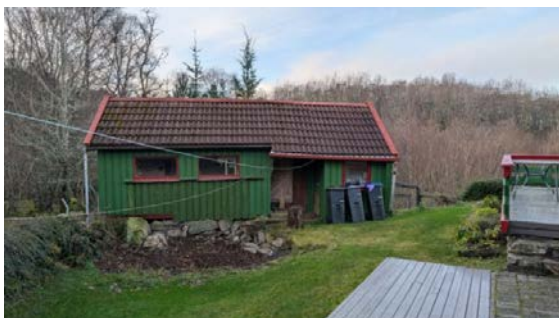
Vesentlige skeivheter. Bygningen er ikke oppmålt eller vurdert.
