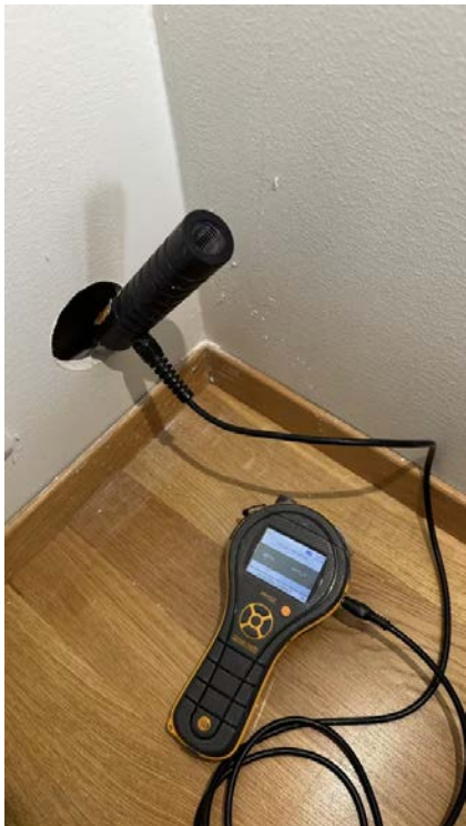
Hulltaking er foretatt fra tilstøtende rom mot våtsone uten å påvise avvik.
