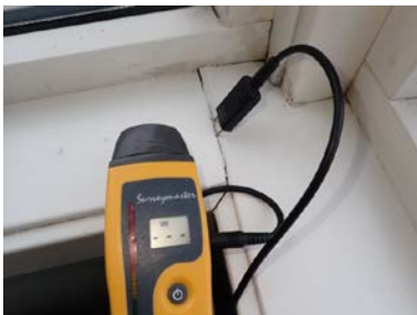
Det er utført fuktsøk med pigger. Ingen forhøyede fuktverdier påvist.
