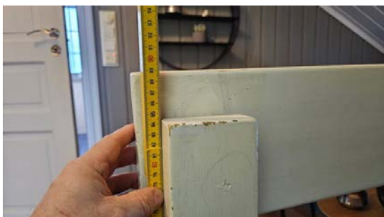
Måling av høyden på rekkverk.
