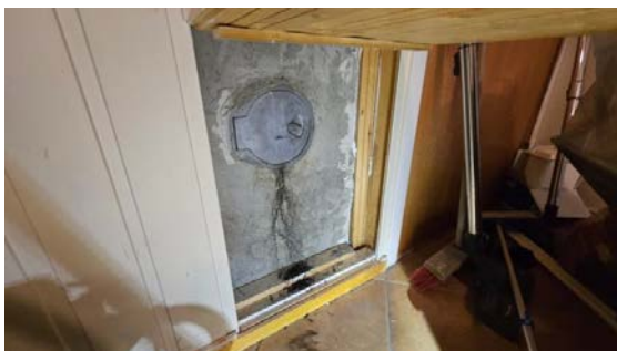
Kontroll av sotluken.
