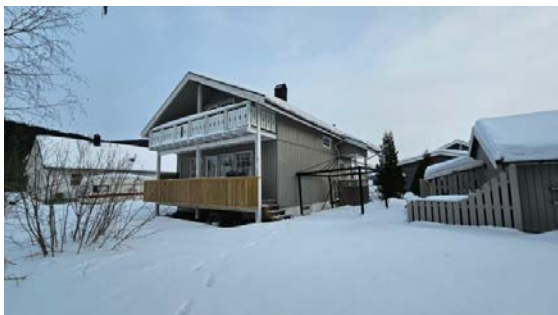
Balkong og terrasse er oppført utenfor fasade vest.
