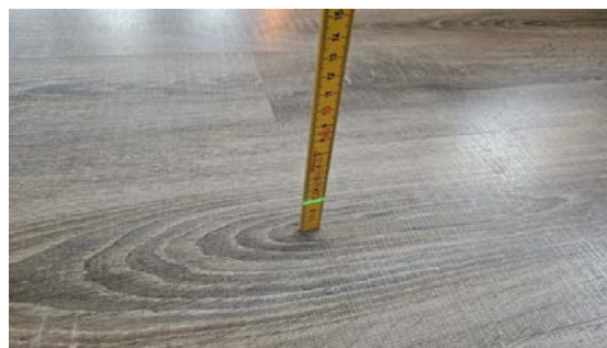
Kontroll av planavvik.
