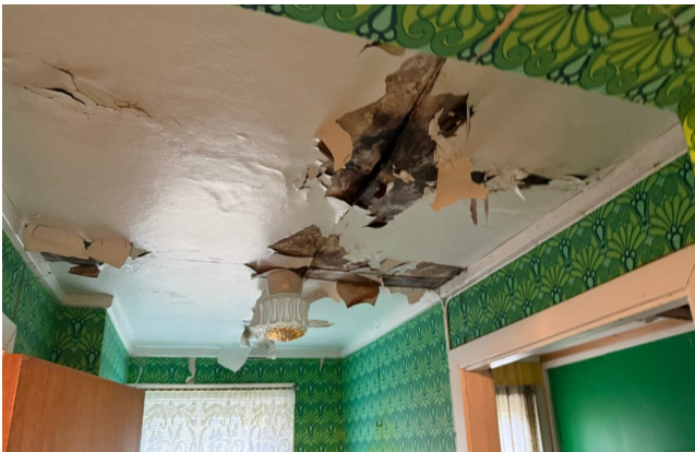
Vannskadet himling, det er ikke mulig å vurdere overliggende konstruksjon.
