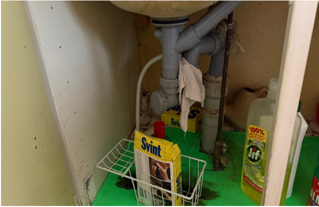
Rørøpplagg under oppvaskkum.
