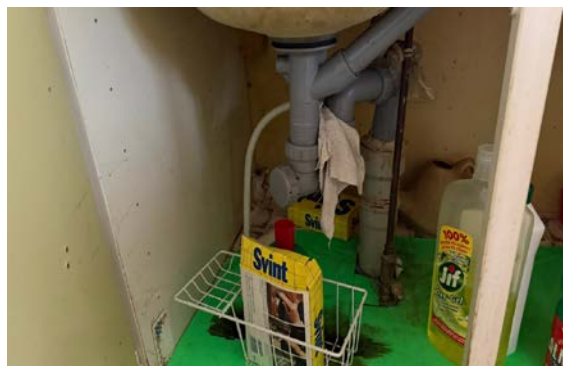
Røropplegg under oppvaskkum.
