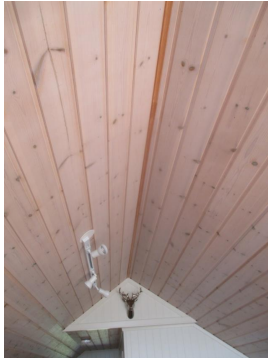
Deler av lukket takkonstruksjon.
