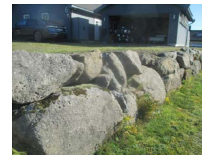
Maskinstablet forstøtningsmur.
