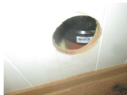
Hulltaking i fra gangen.
