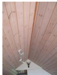
Deler av lukket takkonstruksjon.
