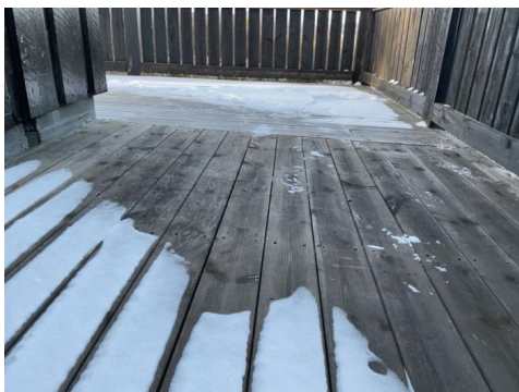
Skjevheter på konstruksjon av dratt ut innfesting mot vegg
