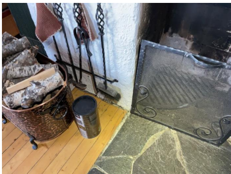
Nært brennbart materiale
